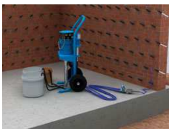
Инъектирование в каменную или кирпичную кладку
