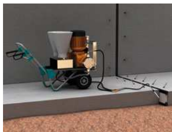
Герметизация деформационных швов
