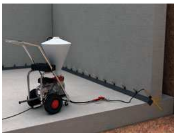
Герметизация рабочих швов
