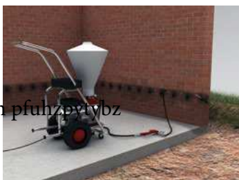
Создание отсечной гидроизоляции
