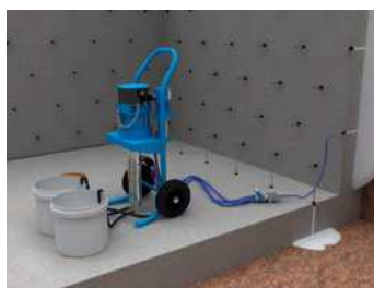
Создание противофильтрационной завесы
