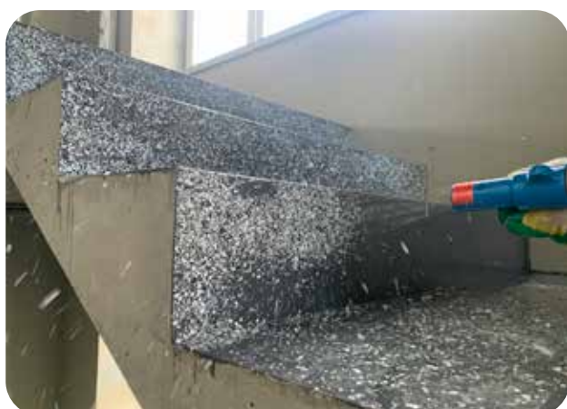
Нанесение цветных флоков механизированным способом
