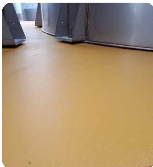
Финишный вид защитного покрытия ДенсТоп ПМ 605 Тровел
