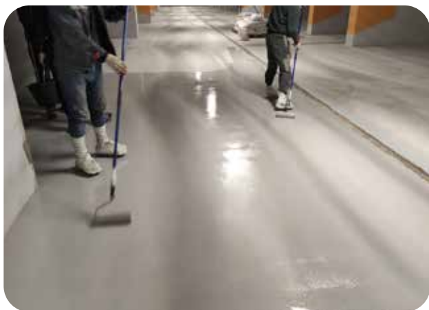
Обработка эпоксидного состава ДенсТоп ЭП 501 с помощью валиков после распределения
