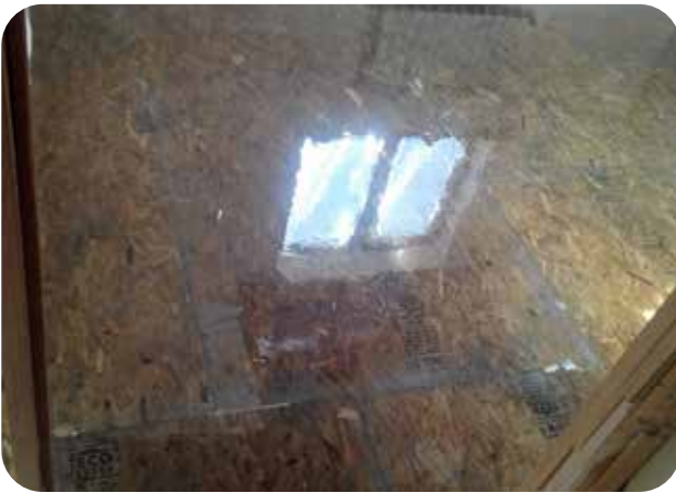
Вид загрунтованного основания ДенсТоп ЭП 104
