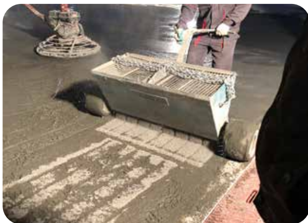
Распределение упрочняющей смеси Стармекс Топ КР скриббоксами
