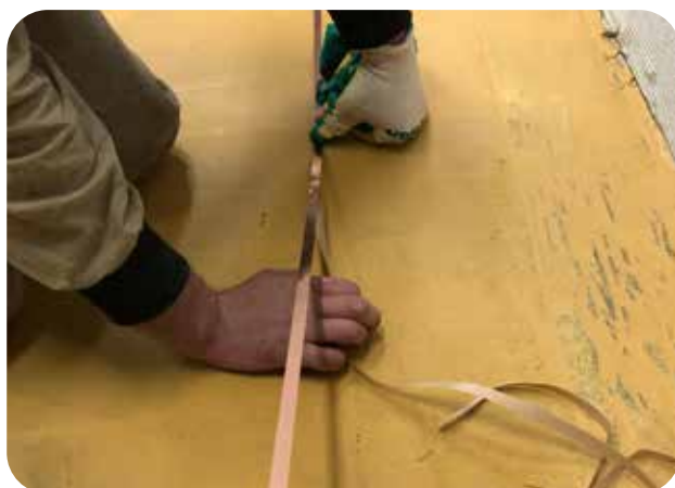
Приклеивание медной токопроводящей ленты на загрунтованное основание
