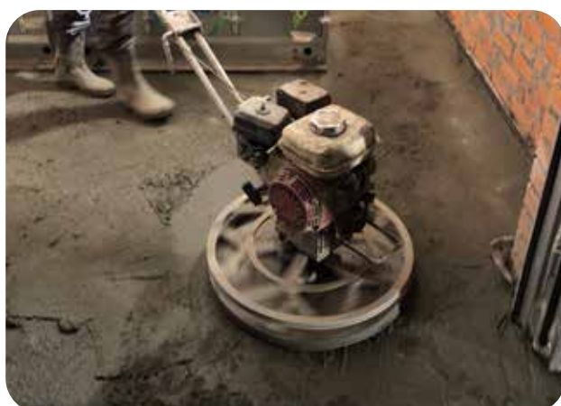
Затирка топпинга специальными машинами (вертолётми)
