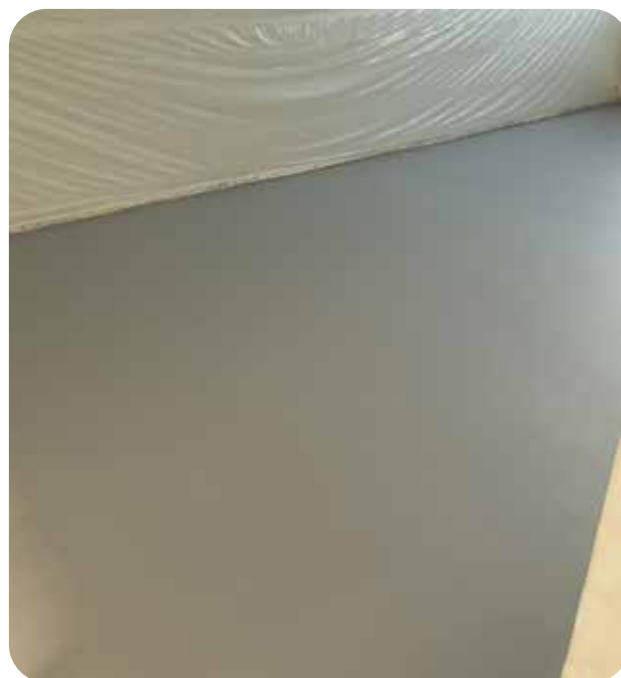
Финишный вид защитного покрытия ДенсТоп ПМ 605 Флоу
