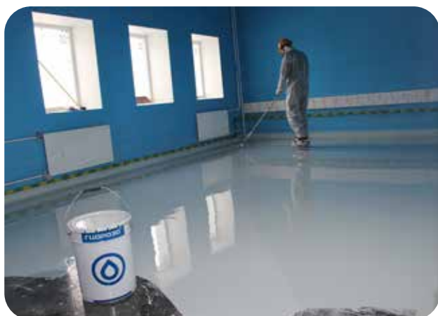
Обработка свежеложенного покрытия Витрапокс 1600А при помощи игольчатого валика
