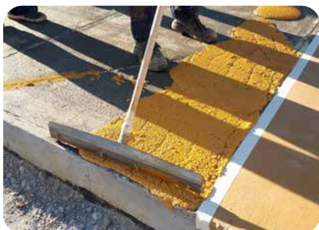
Распределение цементно-полиуретанового покрытия при помощи ракли с регулируемым зазором
