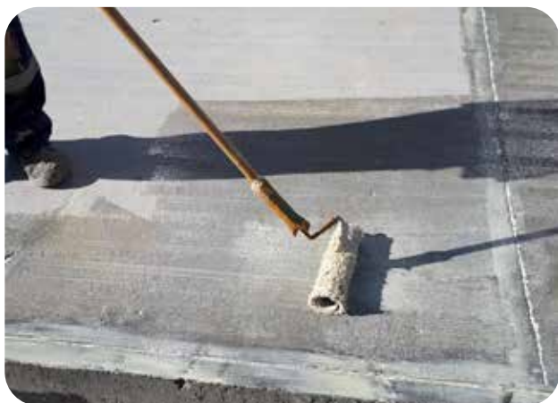
Грунтование поверхности составом ДенсТоп ПМ 600
