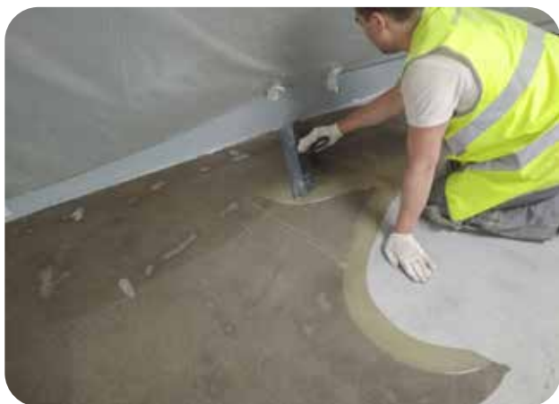
Грунтование поверхности составом ДенсТоп ЭП 106
