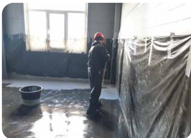
Нанесение первого слоя защитного эпоксидного покрытия ДенсТоп ЭП 201
