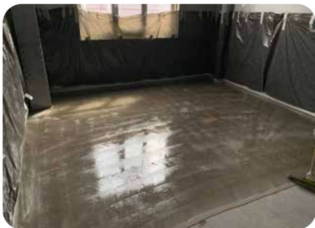
Грунтование поверхности составом ДенсТоп ЭП 100, смешанным с наполнителем ДенсТоп Филлер
