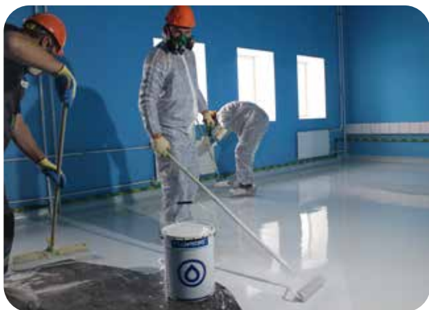
Распределение эпоксидного состава Витрапокс 1600А при помощи ракли с регулируемым зазором
